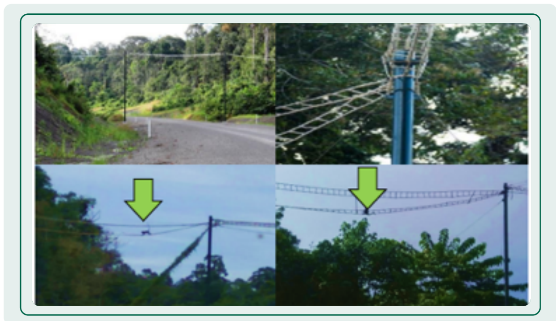
Arboreal bridge for animal crossing Jembatan arboreal untuk jalur perlintasan satwa
