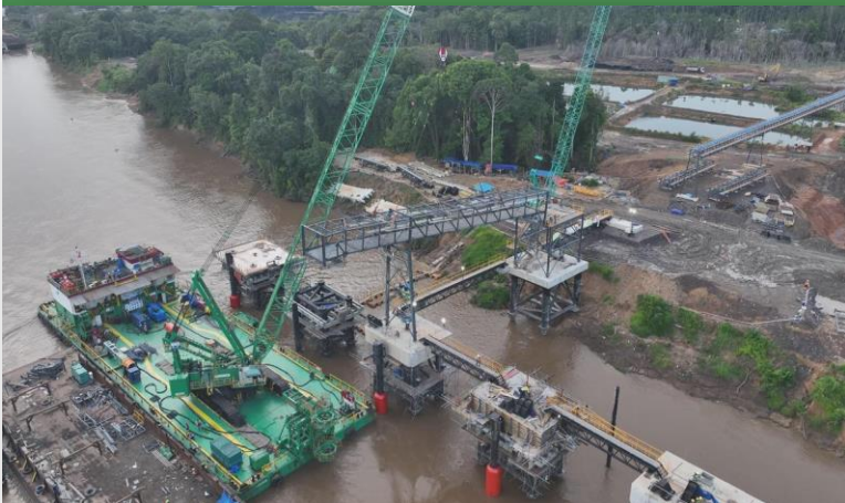
Konveyor Pemuatan Tongkang Kedua
